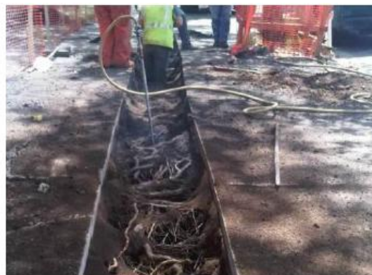
4.attēls. Koku sakņu šurfēšana izmantojot „gaisa lāpstu” metodi („airspade”)
