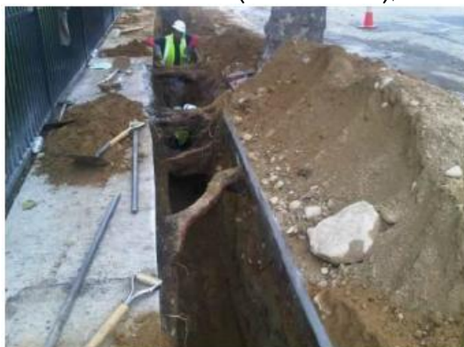
4.attēls. Koku sakņu šurfēšana izmantojot „gaisa lāpstu” metodi („airspade”)
